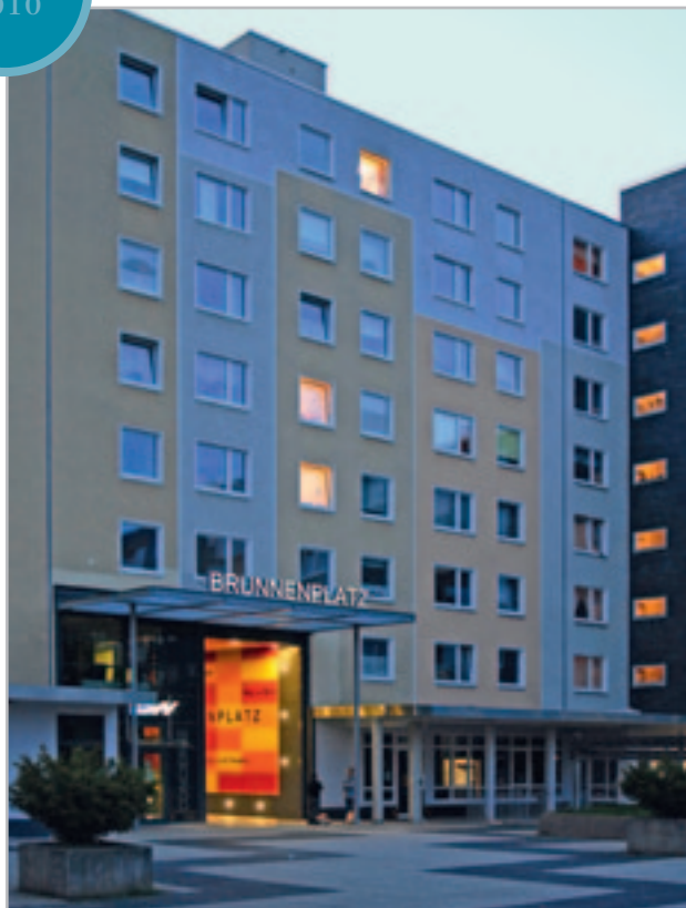
Neugestalteter Gebäudezugang am Brunnenplatz
